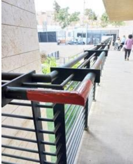
פינת מאחז יד חדה בסמוך לדלת הכניסה, וחלקי פרוזל חדים לאורך מאחז היד במעון לקשיש בגילה.
