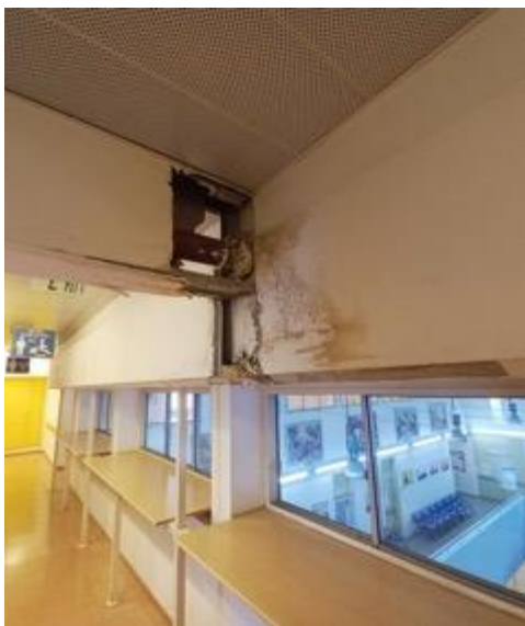
צינור מים שחיפיוו שבור וחסר ובקרבתו ניכרו סימני רטיבות וקורוזיה במינהל קהילתי בגילה.
