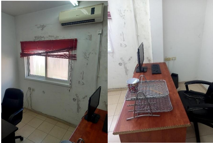
מימין ומשמאל - טיח מתפורר ומתקלף וסימני רטיבות; משמאל - תריסים שבורים וקרועים.
