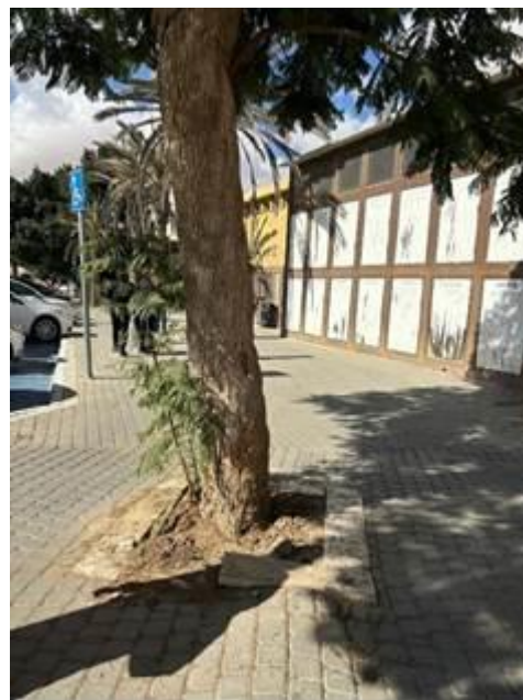
תמונה 9: פגיעת שורשי עצים במרחב הציבורי בדימונה
