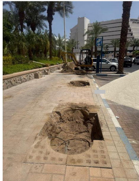
הרחבת בתי גידול והעמקתם ברחוב תרשיש.
