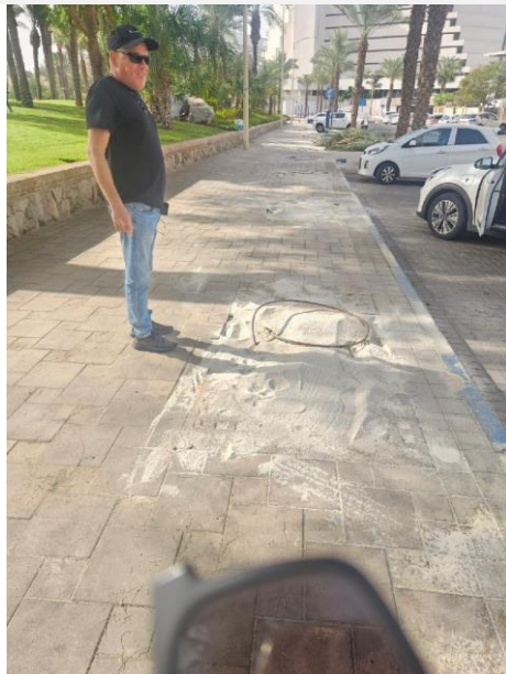
החלפת אדמה בבתי גידול ברחוב תרשיש.
