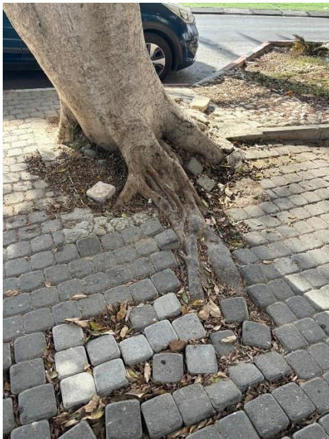
תמונה 9: פגיעת שורשי עצים במרחב הציבורי בדימונה
