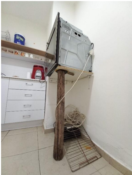
מטבחון הסניף ובו תנור אפייה הנתמך על ידי מוט עץ סדוק ומטקת משחק, מוזן על ידי כבל מאריך וחשוף בצידו.
