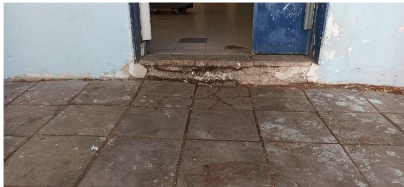
הריצוף בתוך המבנה ומחוצה לו שבור, כמו גם מדרגת הכניסה שאינה מאפשרת גישה לאנשים עם מוגבלות.
