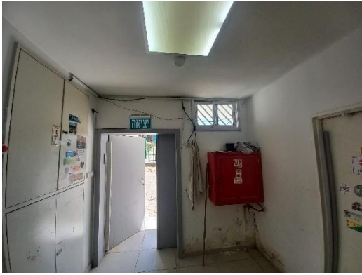
דלת הכניסה, מבט מבפנים - כתמי רטיבות בתחתית הקיר וכבלי חשמל שאינם מעוגנים.
