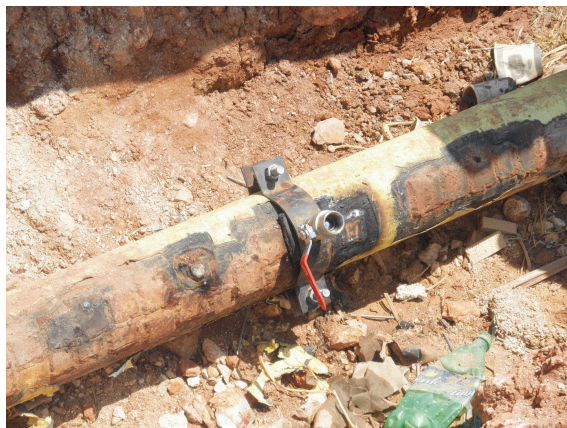
הכנה לגנבת מים בקו "מקורות" המספק מים ליישובים פני חבר ובית חגי. ניתן להבחין בסימנים של גנבות קודמות (שנותקו באמצעות צוהי הניתוק שמפעיל קמ"ט מים).
