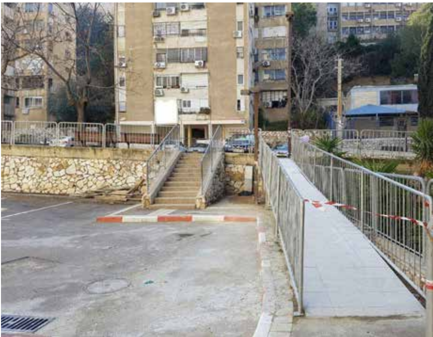
הכבש שהותקן במקבץ הדיור בחיפה
