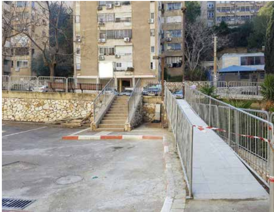
הכבש שהותקן במקבץ הדיור בחיפה
