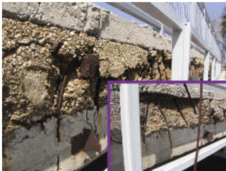
תמונה מס' 2 חשיפת ברזל בחזית מזרחית לגשר המזרחי שמעל נחל הקישון
