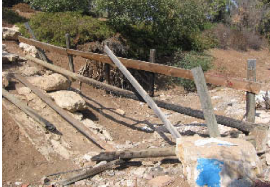
תמונה מס' 6 קריסת גשר עץ להולכי רגל מעל אפיק הניקוז
