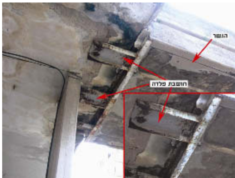
תמונה מס' 5 תושבת הפלדה המחברת את גשר צ'רניאבסקי למרכז המסחרי
