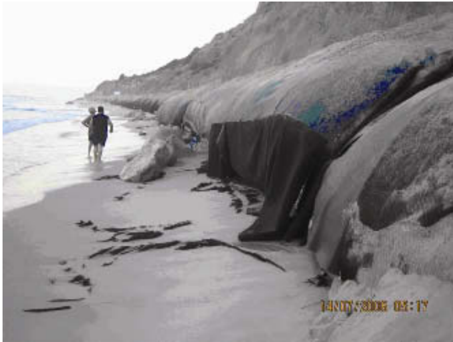
אשקלון - נזקים שהתגלו בגלילי ה-geotube
