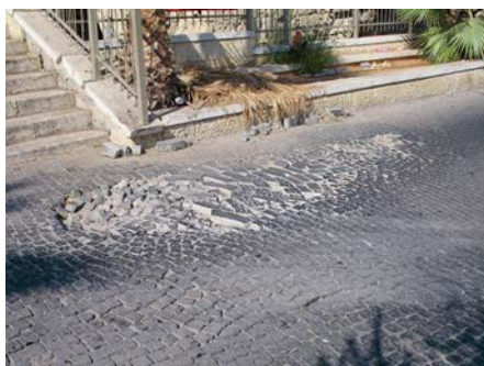
בור בכביש אבנים משתלבות ברח' קהילת דטרווייט ברמלה (נובמבר 2012)
