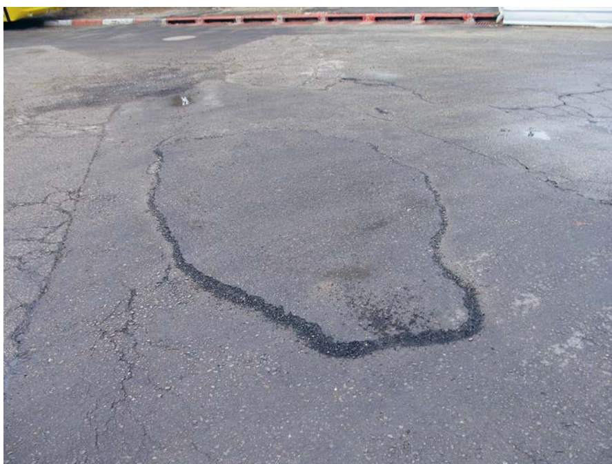
בליטה בכביש ברח' עמיחי ברמלה לאחר חפירה של תאגיד המים (ינואר 2012)
