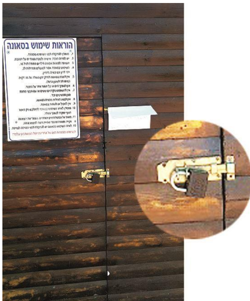
ברח המאפשר סגירת הסאונה מבחוץ כשהיא פועלת. צולם על ידי צוות הביקורת ב-19.6.18.
