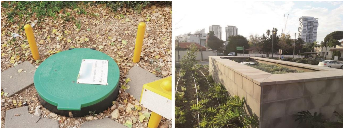
מימין - צובר בהטמנה עילית; משמאל - צובר בהטמנה תחתית צולם על ידי צוות הביקורת, ספטמבר 2018
